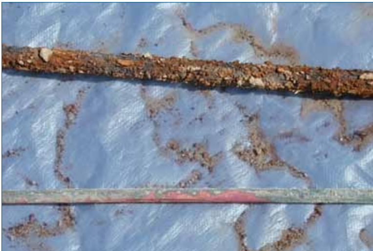
Wykopane po 12 latach.
