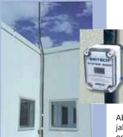
Przewód odprowadzający ERITECH ERICORE łatwo można zainstalować na gotowych obiektach. Wkładka: Licznik wyładowań piorunowych ERITECH® LEC IV) zainstalowany do rejestrowania uderzeń w system ERITECH® SYSTEM 3000.
